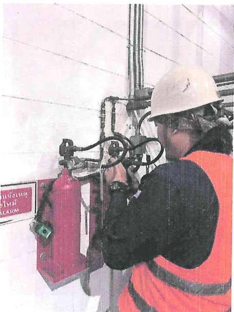
ถอดหัวถัง Pilot Cylinder ก่อนการทดสอบจริง และใส่กลับเมื่อทดสอบแล้วเสร็จ
