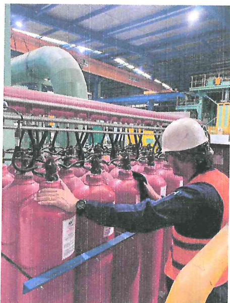
ทำความสะอาดอุปกรณ์ถัง CO 2 Cylinder ด้วยผ้า ชุบน้ำยาทำความสะอาด
