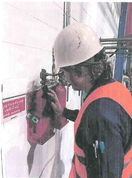
การทำความสะอาดอุปกรณ์ถัง Pilot Cylinder ด้วย การเช็ดทำความสะอาดด้วยผ้า
